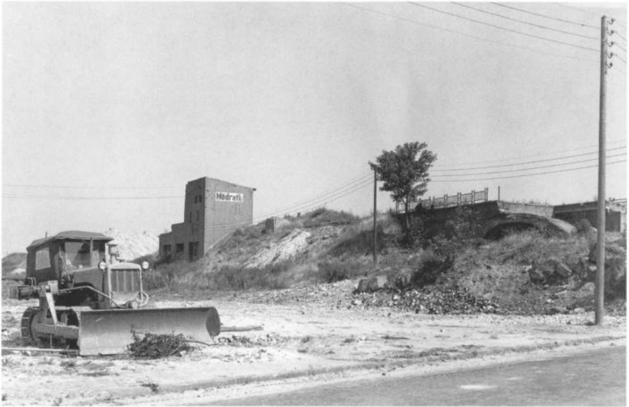
22. Rheinisches Braunkohlengebiet: Abbruch des Bahnhofs Mödrath, ca. 1963.
